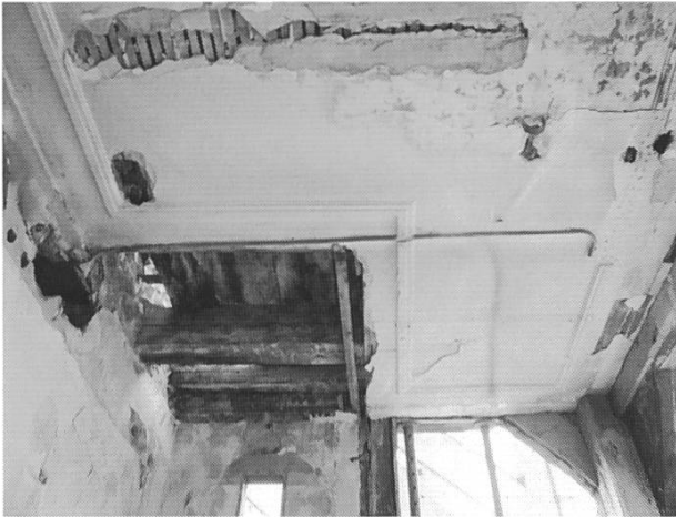
Gipsdecke im Erdgeschoss mit Fries, das bereits Rücksicht auf den Einbau des Aborts nimmt.
