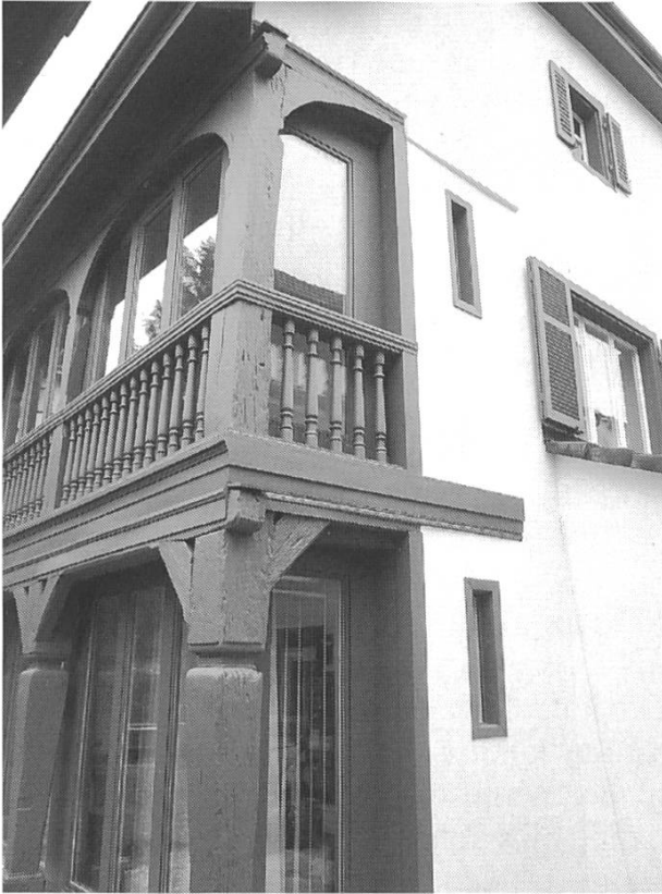
Westseite der Laube mit der Westwand der Abort-Einbauten.
