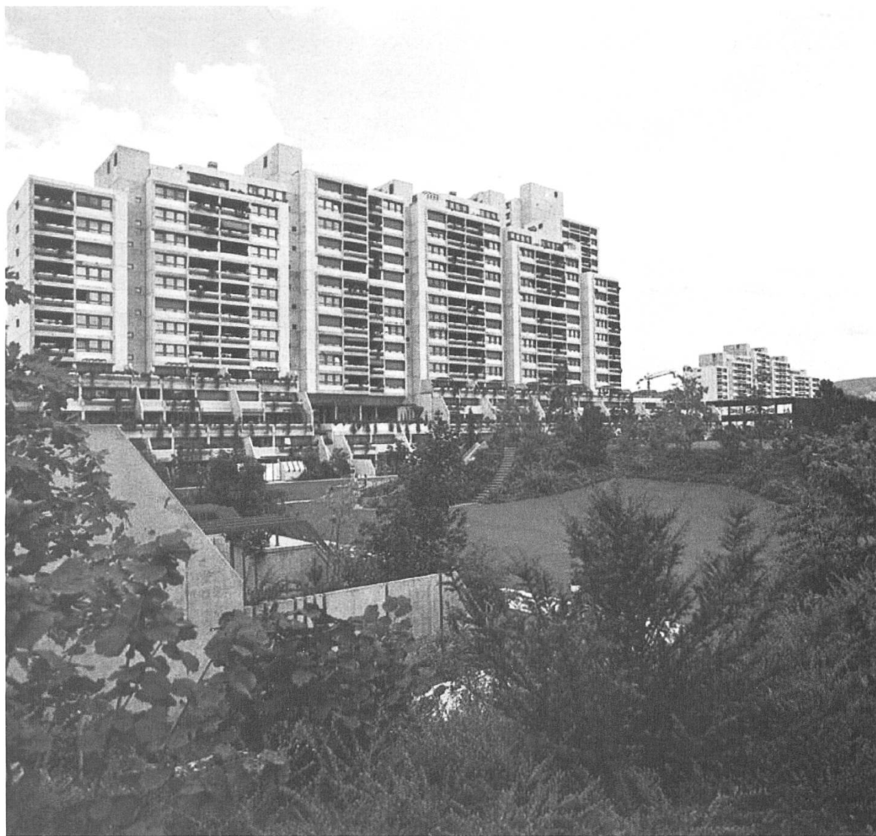
Abb. 6: Wohntürme und Grünanlage der Siedlung Liebrüti , aus: Liebrüti – Grösser wohnen , Basel 1976.
