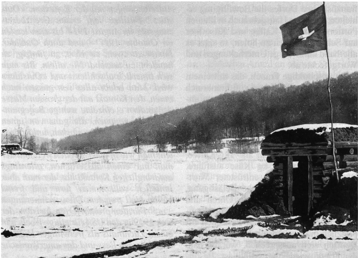
Abb. 8: Splittersichere Unterstände im Largzipfel. Links des kleinen Unterstandes hinter dem Ufergehölz erkennbar sind die Ruinen der Largmühle.
