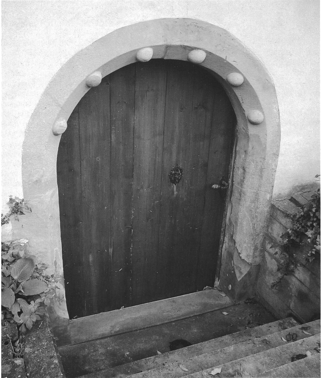
Abb. 2: Bättwil, Hauptstrasse 15. Kellereingang mit Kugelfries. (Foto: Kaspar Egli)
