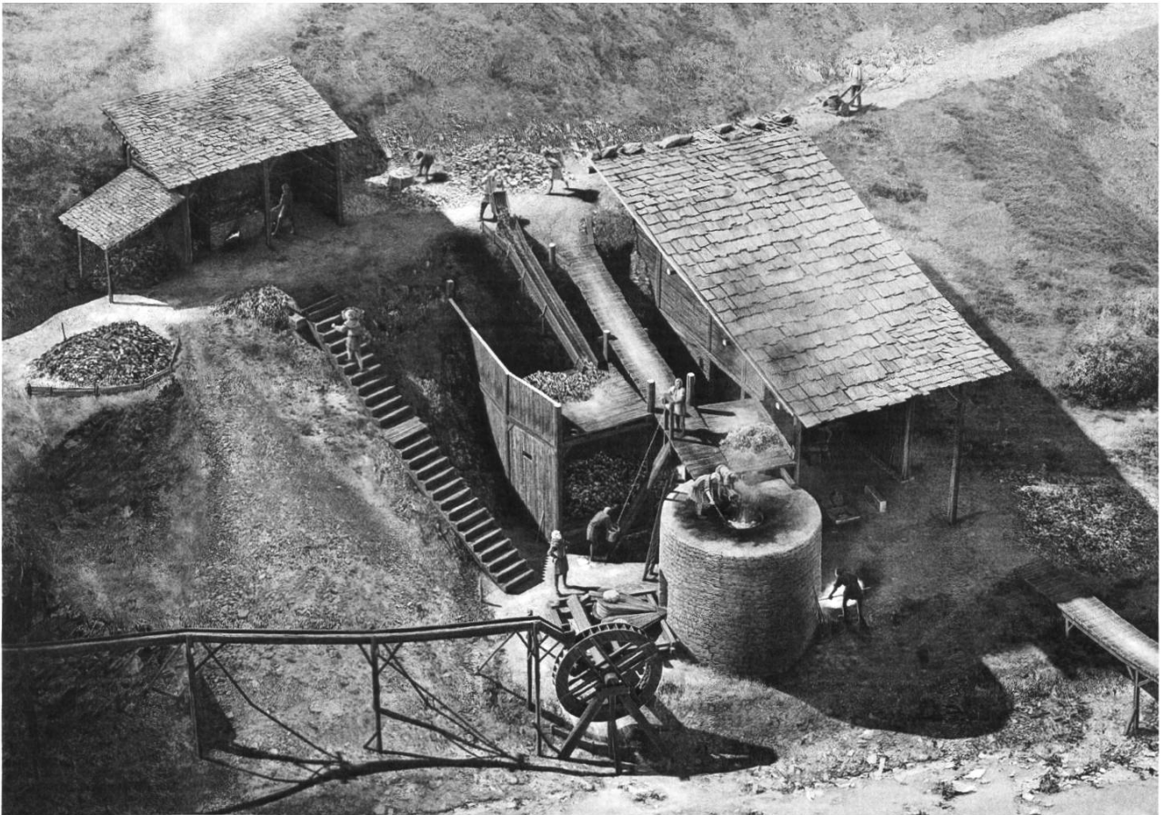
Bild 4: Das Werkgebäude. Rekonstruktion des Hochofens aus dem 13. Jahrhundert. Beim zweiräumigen Werkgebäude wurde links das Dach nicht eingezeichnet, um Einblick ins Innere zu ermöglichen. (Illustration Joe Rohrer, bildebene)
