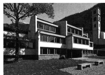
Schulhaus Brusio (Foto: Ralph Feiner)
