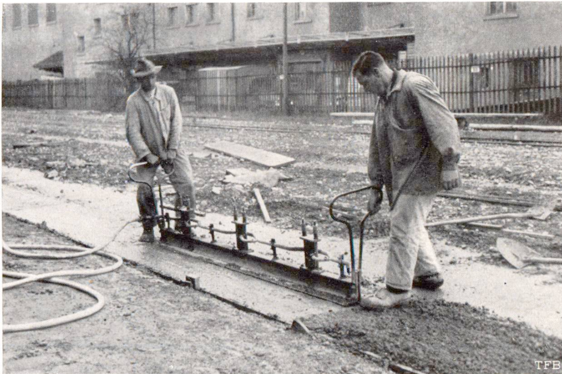
Fig. 1 Vibration superficielle au moyen du «Vibropil» lors de la construction d'une route en béton à la gare-marchandises de Zurich. Direction des travaux : Routes en béton S. A., Wildegg. Exécution : Prader et Cie., S. A., Zurich.
