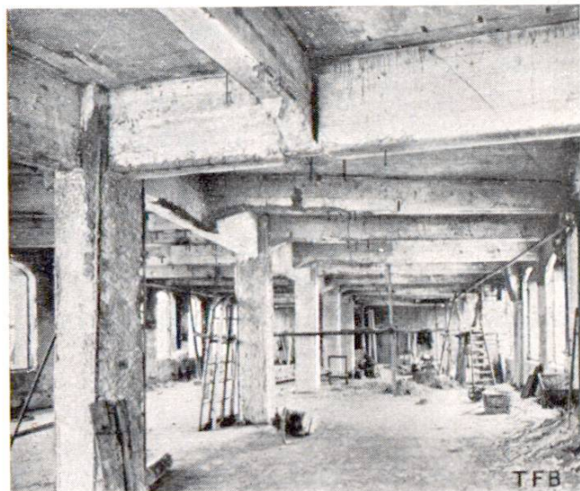
Fig. 2 Dalle en béton armé après l'explosion et l'incendie d'une fabrique de crayons à Nuremberg
