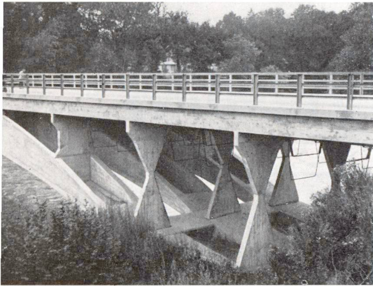
Détail du pont sur l'Arve près de Genève. Ing. R. Maillart.
