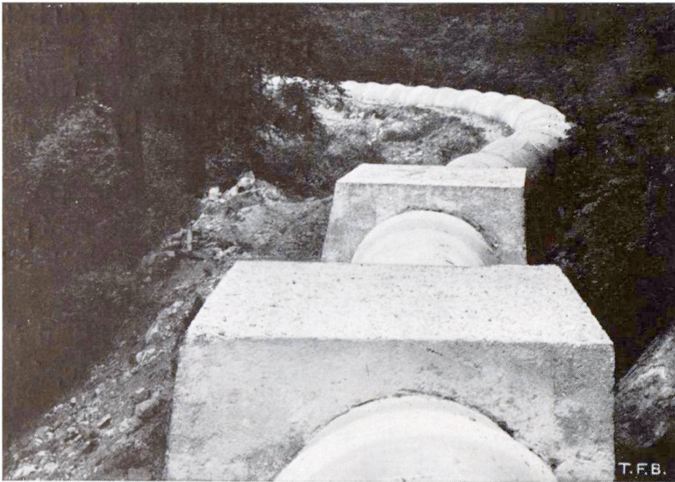
Fig. 5 Conduite forcée d'usine hydro-électrique. Tuyaux en béton centrifugé de 125 cm. \odot pression de 4 at.
