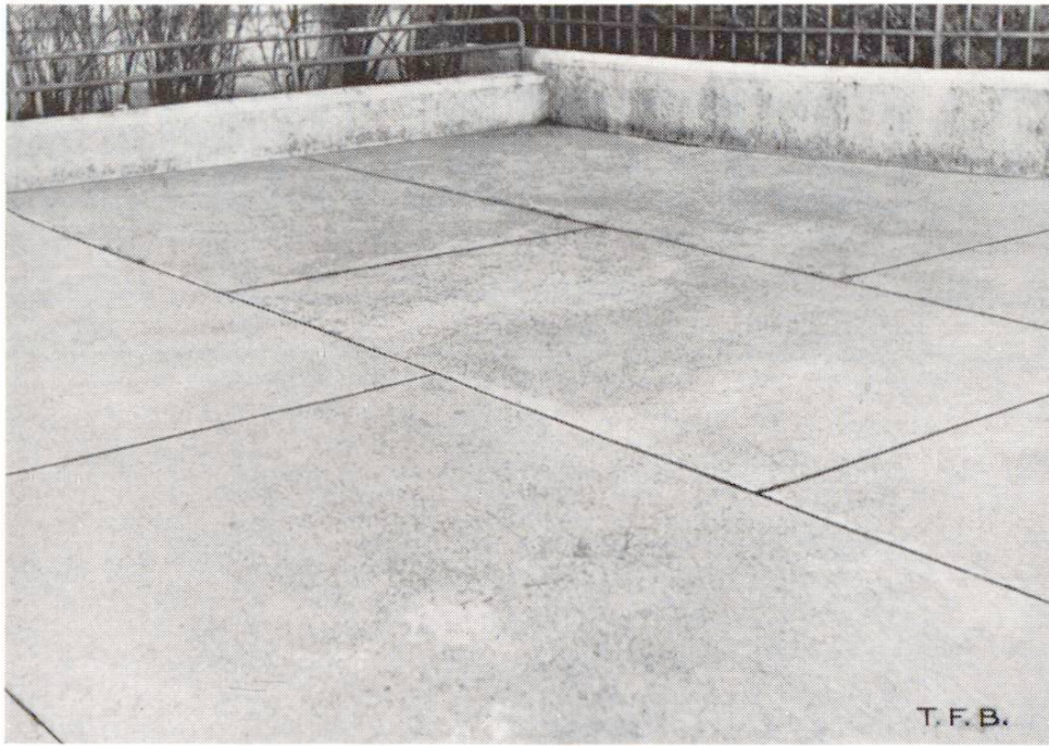
Fig. 1 Revêtement en ciment sans fissures reposant sur une solide couche de fondation
