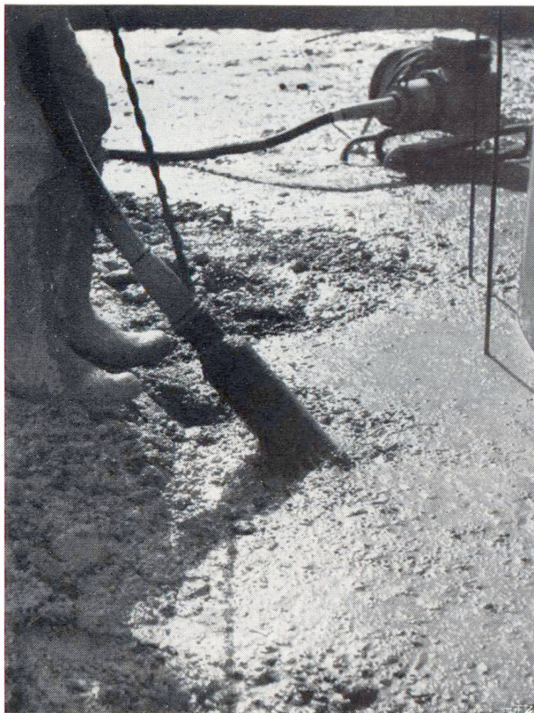
Fig. 5 Barrage de Rossens vibration du béton avec un vibrateur à aiguille. (Com- munié par l'Entreprise du Barrage de Rossens, l'Entre- prise No. 16/1947)
