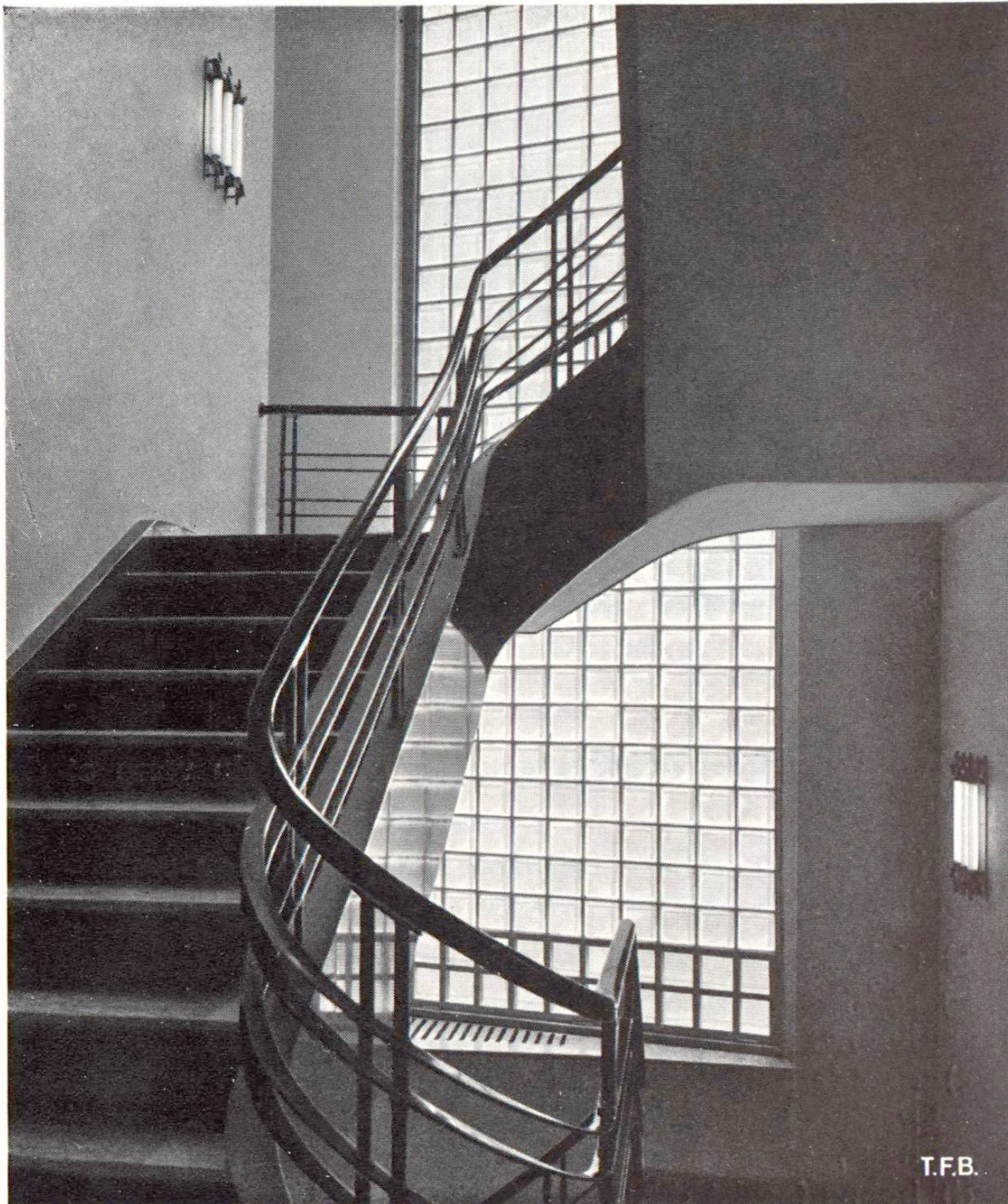
Fig. 5 Paroi de cage d'escalier en béton translucide
