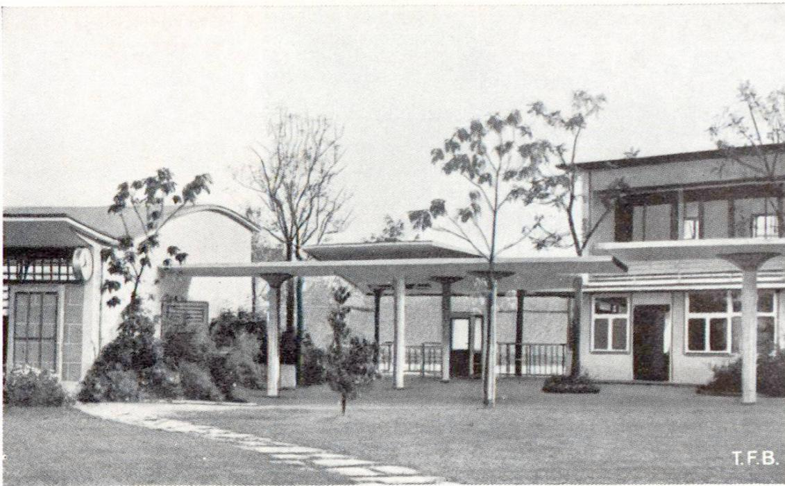
Fig. 7 Entrée des bains à ciel ouvert d'Allenmoos, à Zurich. Constructions brutes en béton armé. Toits-champignons isolés pour les passages couverts. A gauche, vestiaires à toit élargi en béton armé
