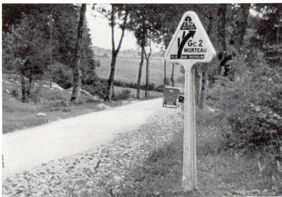
Fig. 4 Le premier indicateur avancé du monde, placé par Michelin en 1930. Il est entièrement en béton
