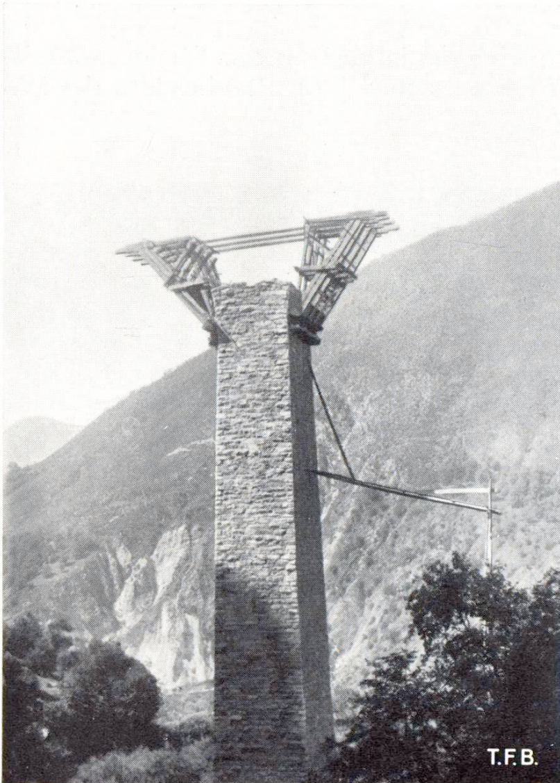
Fig. 5 Construction d'une pile de pont
