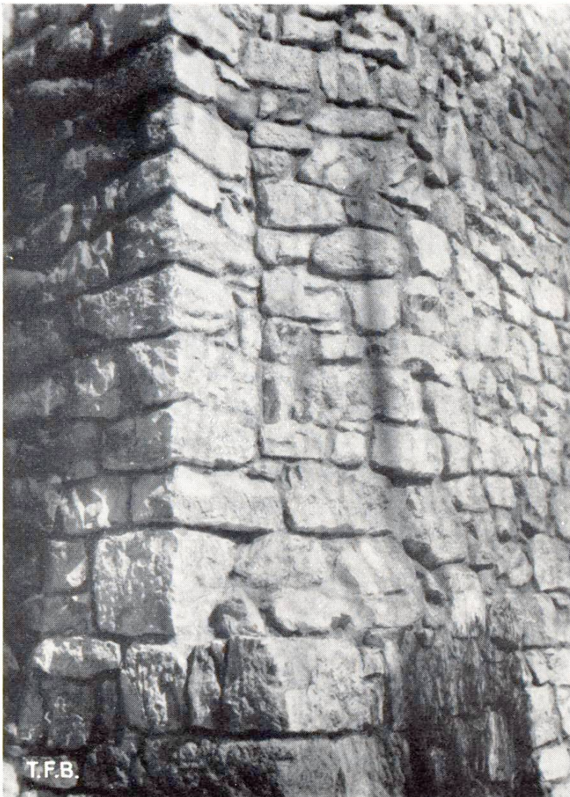
Fig. 2 Fortifications médiévales construites en chaux hydraulique
