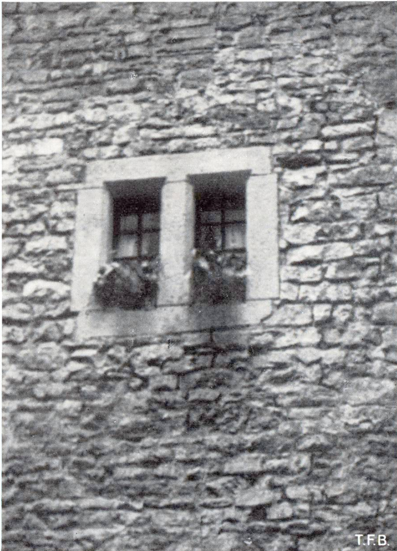
Fig.5 Maçonnerie de la fin du moyen âge. Habsburg
