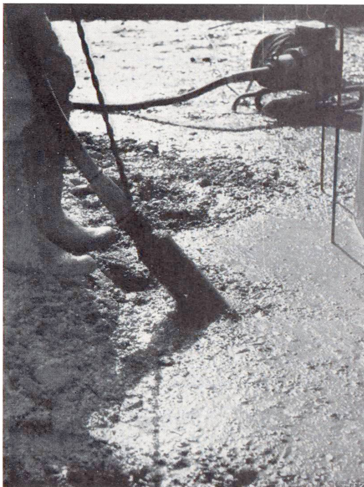
Fig. 5 Vibration à l'aide d'une aiguille, jusqu'à ce que l'eau et les bulles d'air apparaissent à la surface
