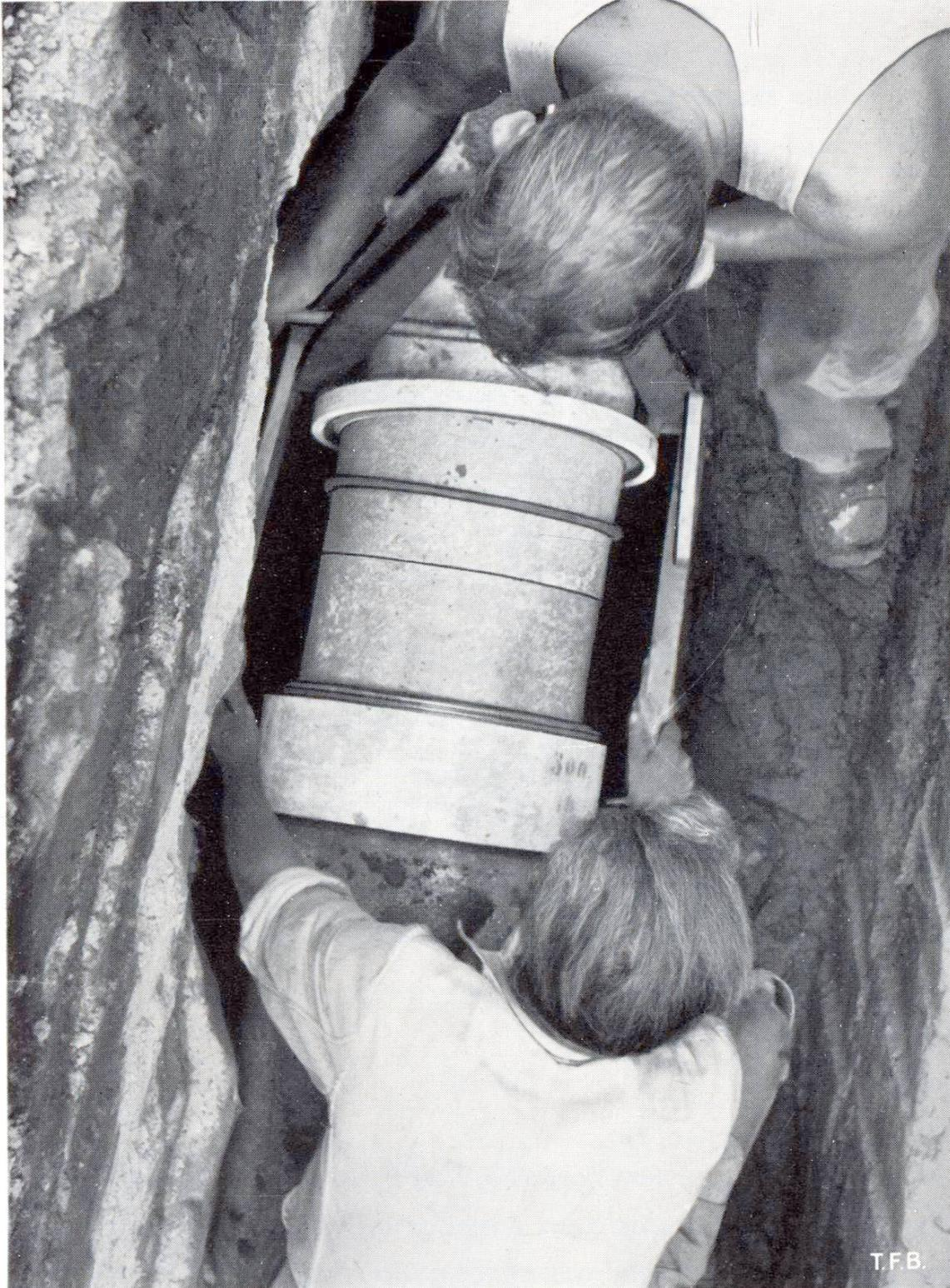
Fig. 7 Montage d'une conduite de 300 mm pour 18 atm.
