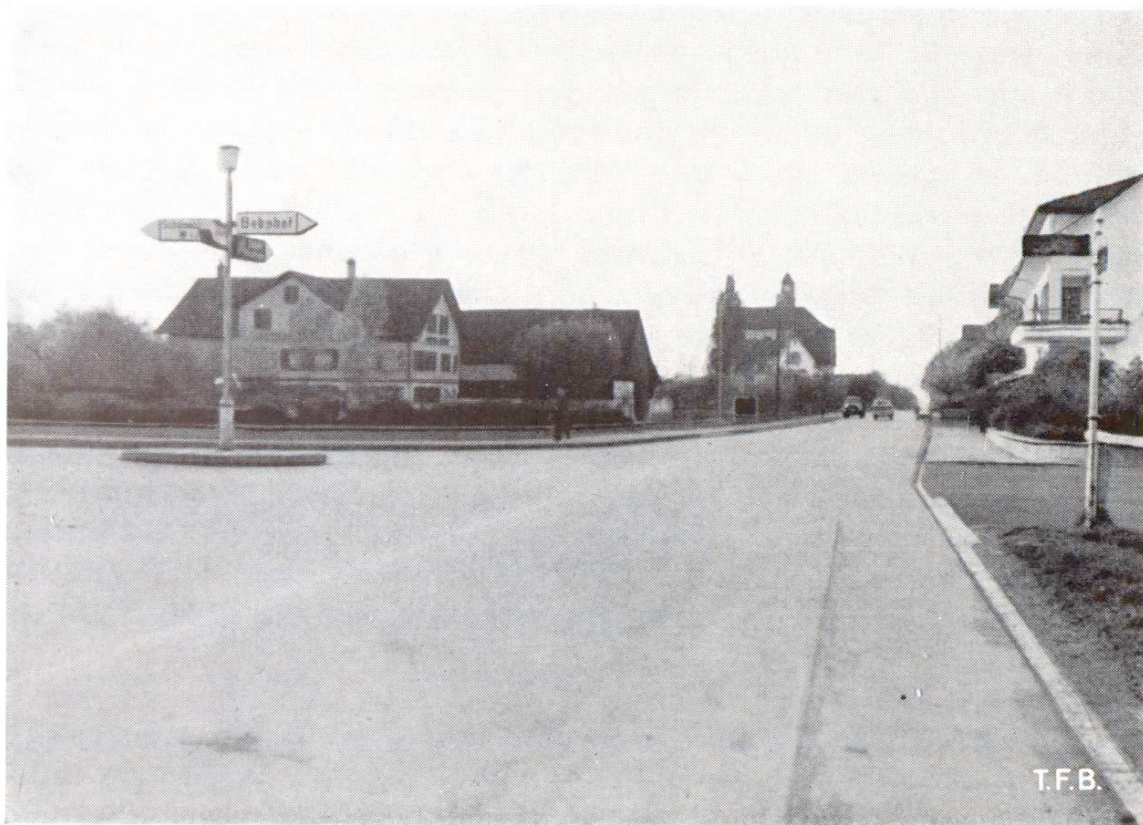
Fig. 12 La place du village de Kradolf. Revêtement de la chaussée construit en 1932, îlot central et trottoirs en 1950 et 1952
