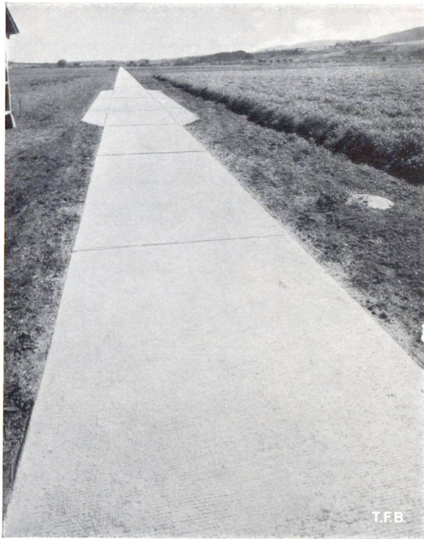
8 Fig. 21 Chemin d'améliorations foncières près d'Orbe VD, avec place de croisement. Largeur 2,80 m. Construction de 1951
