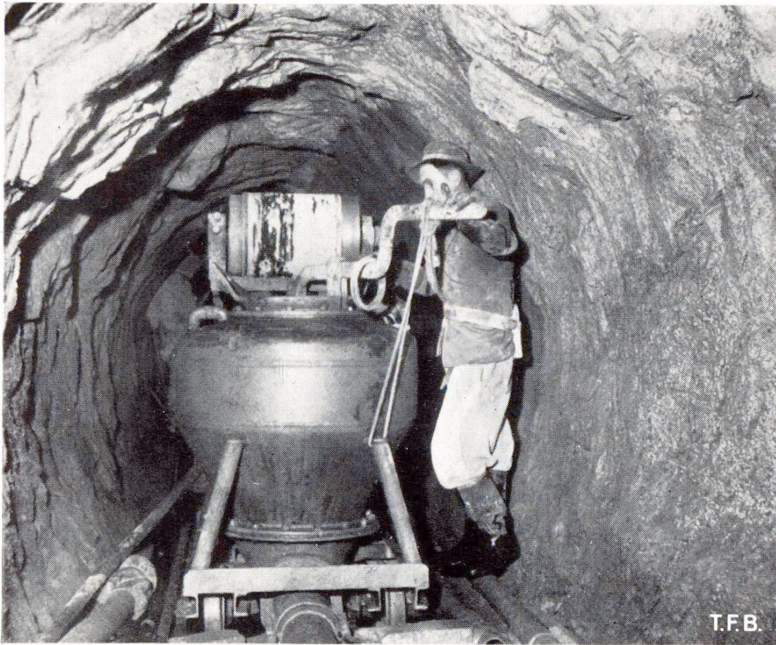
Fig. 4 Bétonnage dans le puits blindé de l'Oberaar avec un appareil Johnny
