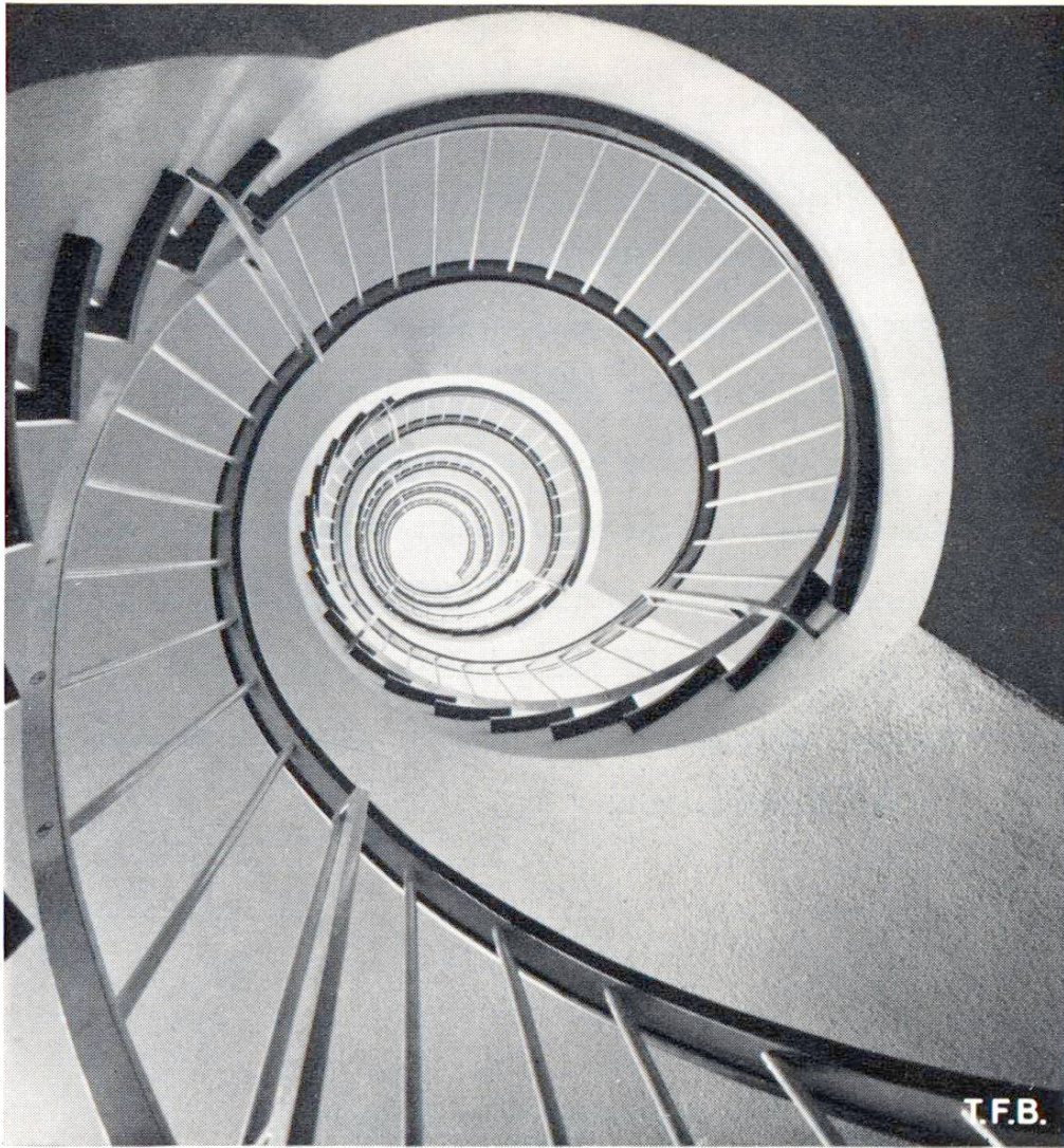
Fig. 4 Escalier dans un bâtiment locatif
