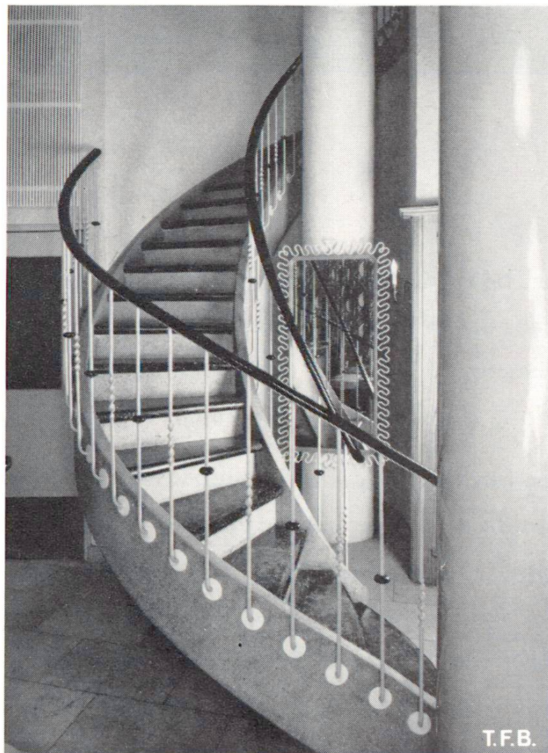
Fig. 5 Escalier à limon en béton poli dans un restaurant. Les marches sont recouvertes d'un tapis en caoutchouc (Photo: O. Pfeifer, Lucerne)
