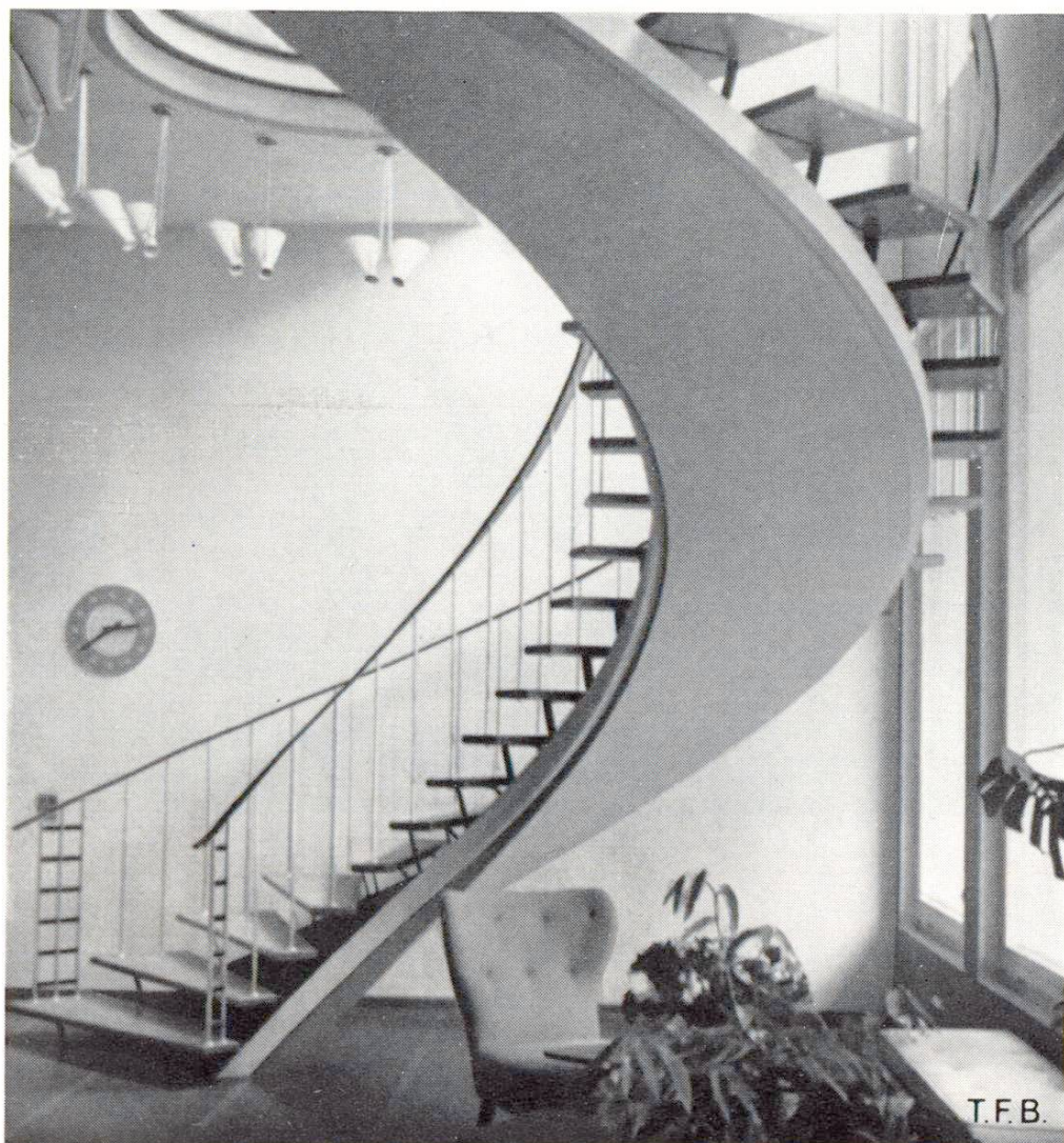
Fig. 3 Escalier dans un magasin. Marches en bois fixées sur une dalle en béton
