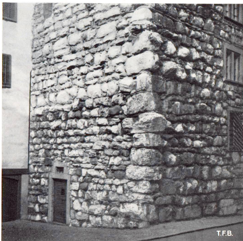
Fig. 1 Muraille de 3 à 4 m d'épaisseur en blocs erratiques petits et gros à peine taillés. Age env. 900 ans
