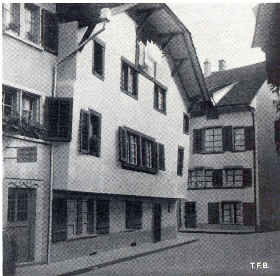
Fig. 4 Une maison dont les étages avancent sur la rue en porte-à-faux. Les habitants cherchaient ainsi à gagner un peu de place. Ce bâtiment semble aussi avoir, au cours du temps, perdu la verticale
