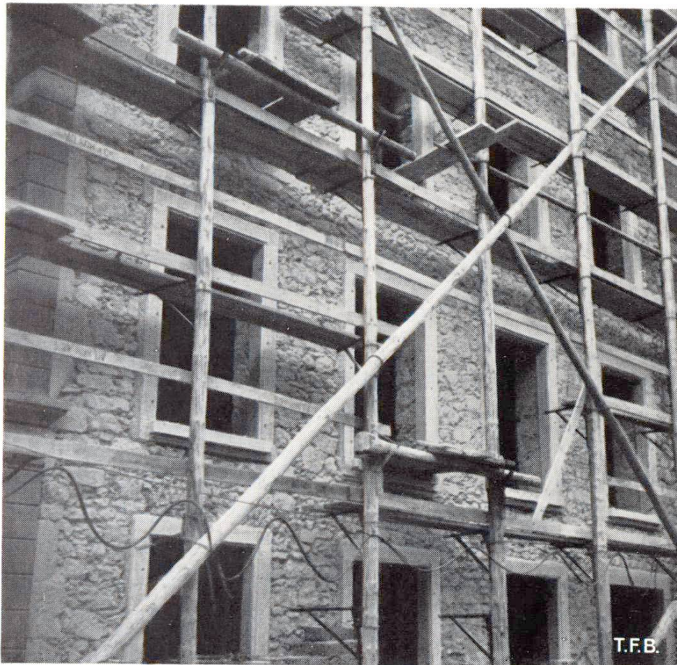
Fig. 6 Rénovation. Sous le crépis, on a vu apparaître une très vieille maçonnerie en moellons
