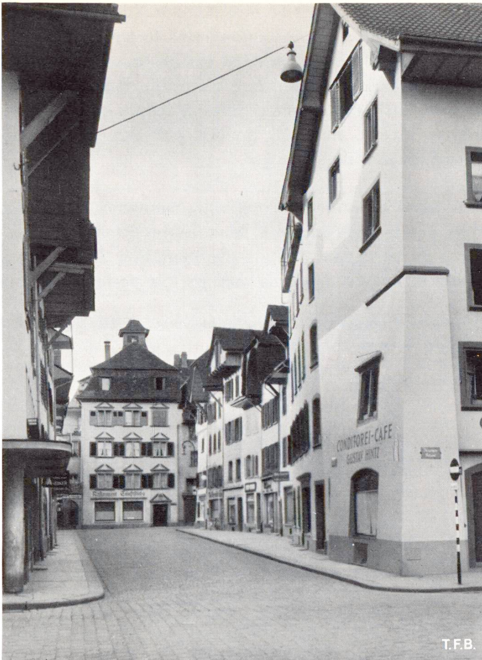
Fig. 3 Grande maison d'angle avec solide contrefort. Au fond, la première maison de cette ville construite en style néogothique vers 1700
