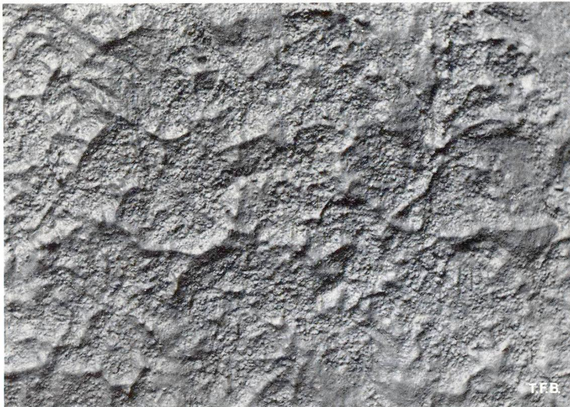
Fig. 6 Crépis décoratif et coloré en mortier de chaux hydraulique
