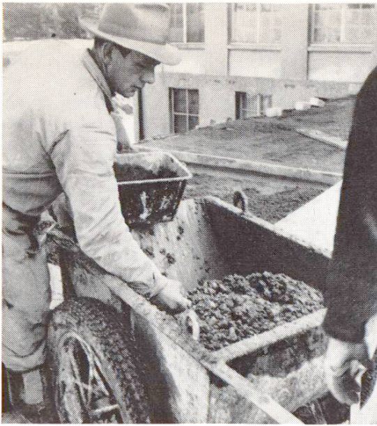
Fig. 3 Prélèvement d'un échantillon partiel à la mise en place du béton
