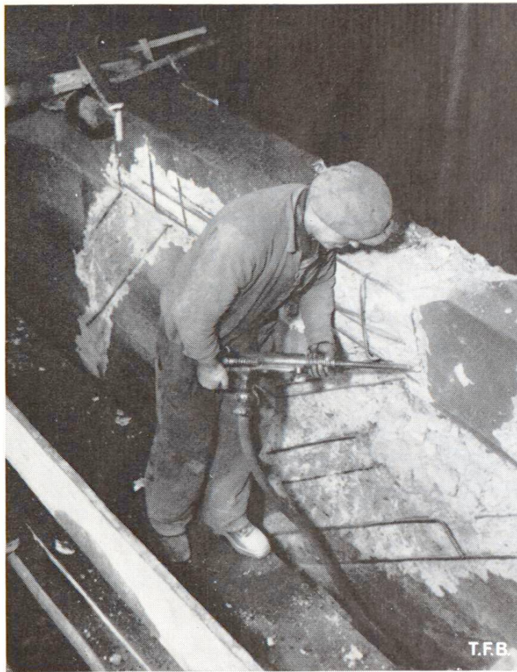
Fig. 3 Repiquage d'un béton fortement endommagé. Le marteau piqueur est tenu obliquement afin qu'il n'entame pas la partie saine de l'ouvrage
