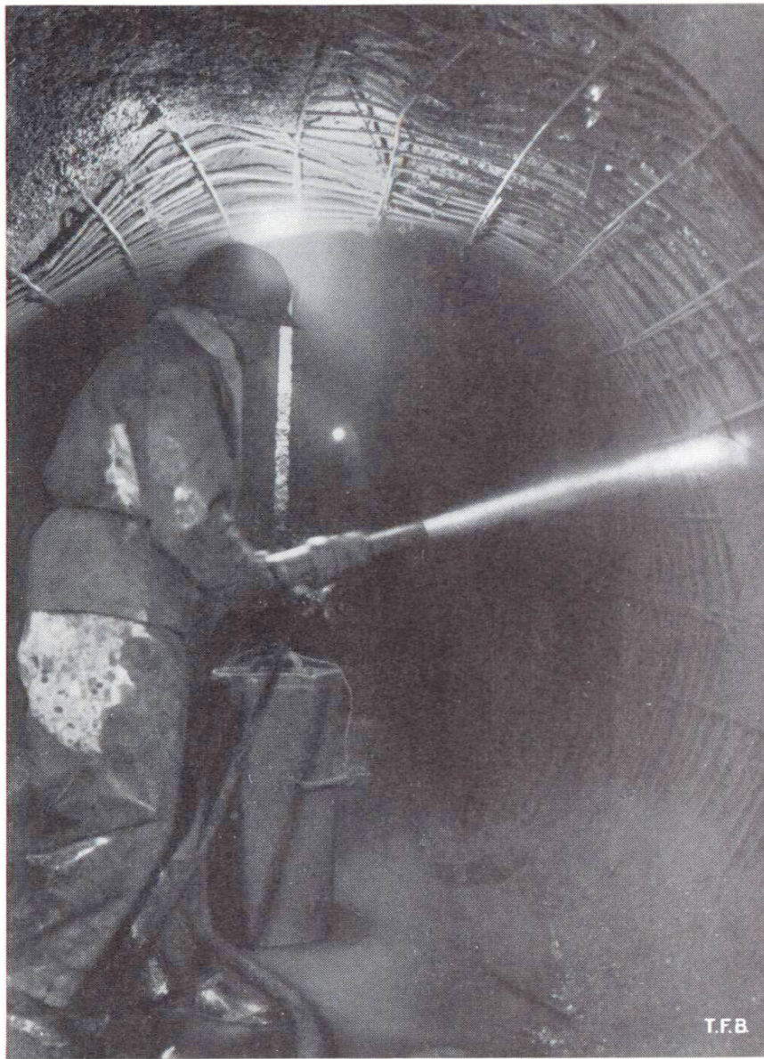
Fig. 3 Revêtement armé en gunite pour rocher particulièrement friable
