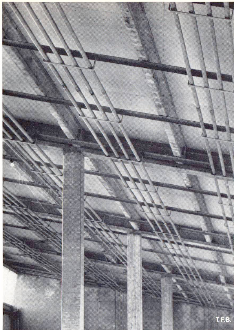
Fig. 7 La charpente formée des fermes et des pannes et l'installation de chauffage suspendue au plafond. (Photo: Jürg Ganz.)
