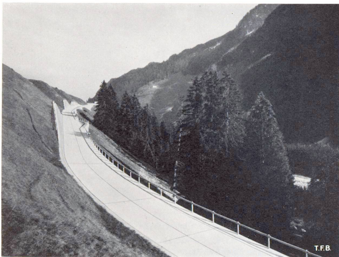
Fig. 3 Entre les points 1126 et 1066, dans la descente vers la vallée du Rhin, on a dû construire de grands murs de soutènement. La photo donne une idée de la parfaite visibilité obtenue sur la route en béton très claire
