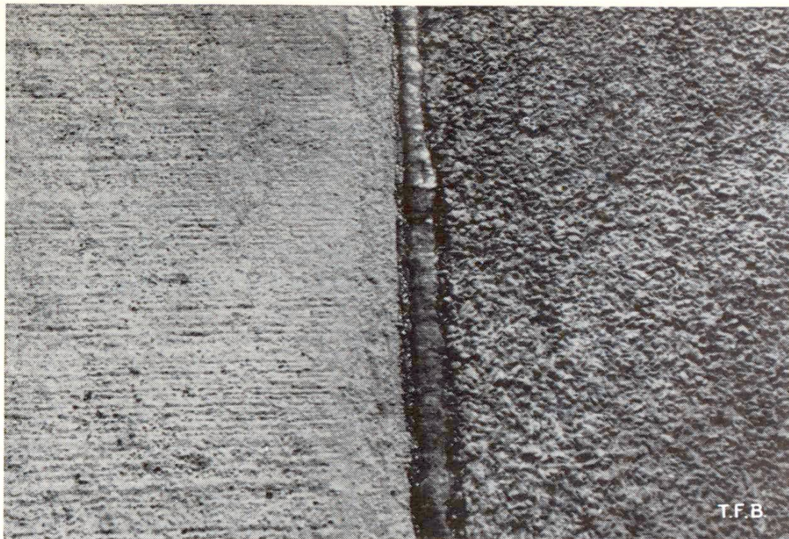
Fig. 4 Structure de la surface d'un revêtement en béton ordinaire à gauche, spécialement rugueux, à droite. Le revêtement rugueux comporte une couche de 3 cm de béton CP 450 composé de gravillon concassé 3/8 mm sans sable
