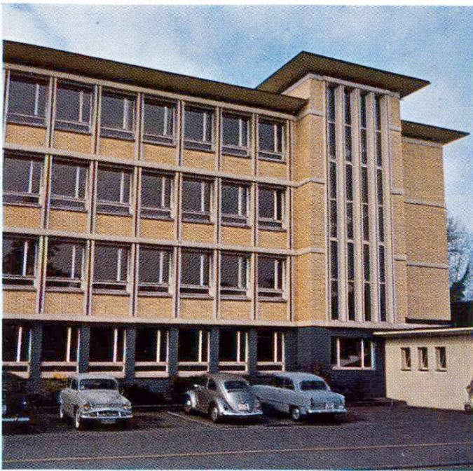
Bâtiment administratif. Charpente en béton armé avec garnissage en maçonnerie de terre cuite
