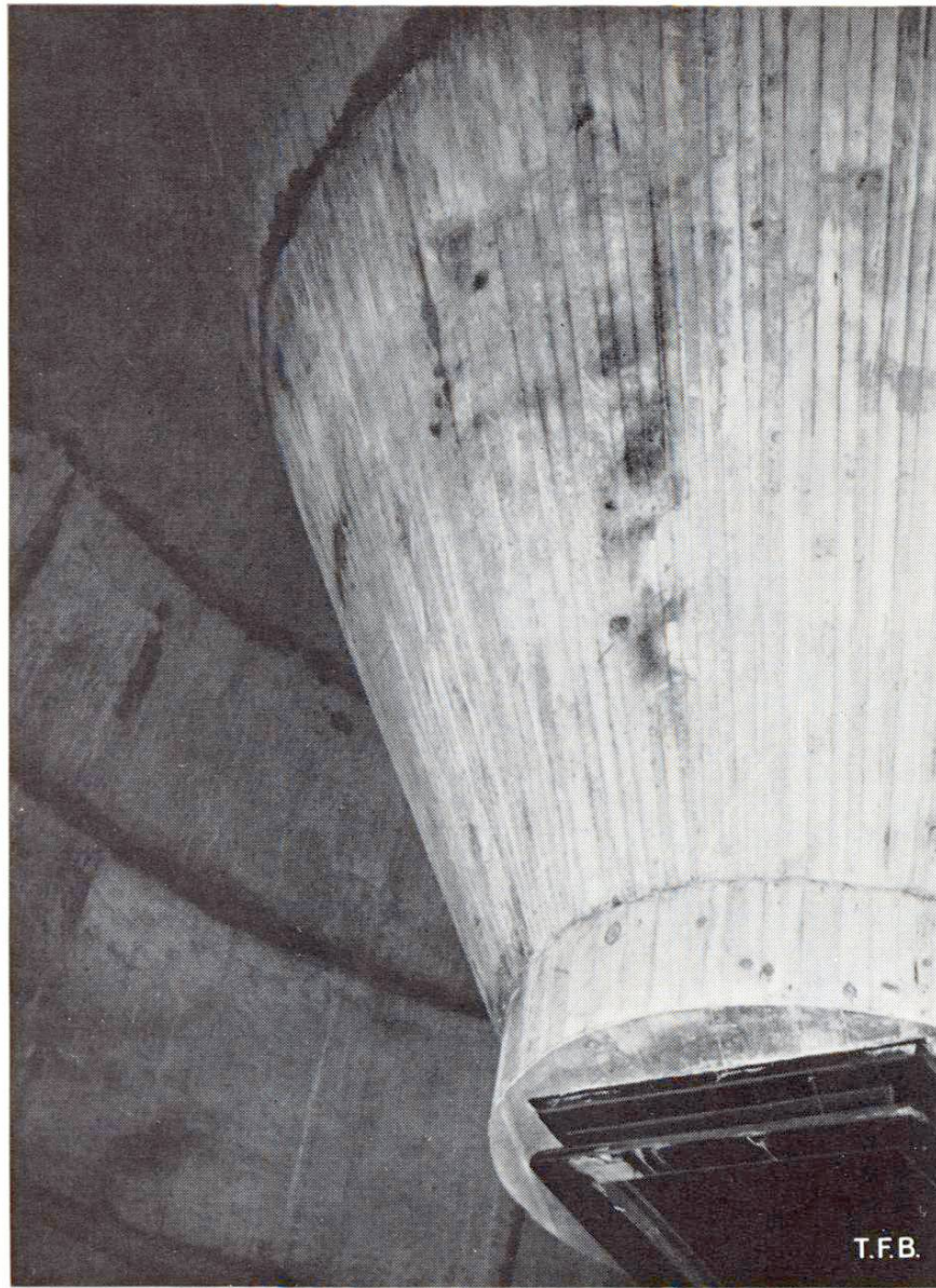
Fig. 5 Entonnoir à cendres avec registre de la cheminée de Wildegg
