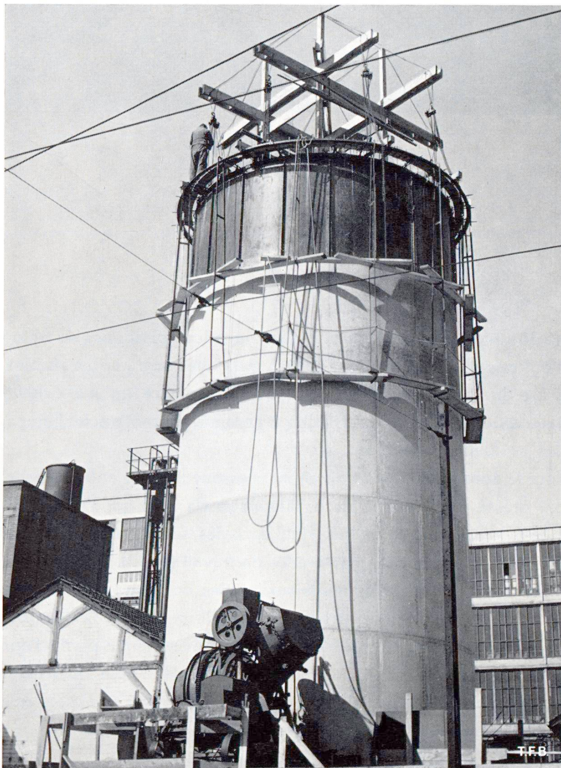
Fig. 3 Cheminée de la CIBA en construction
