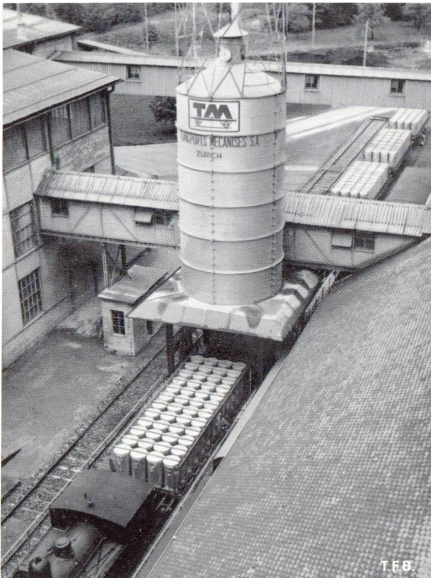
Fig. 3 Le silo de chargement des «Transports Mécanisés», avec les bidons de 400 kg placés sur un wagon spécial
