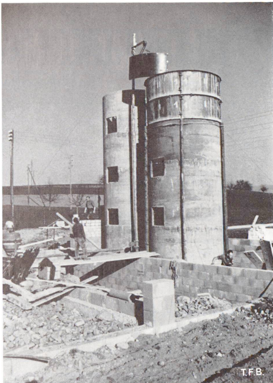
Fig. 2 Bétonnage de silos tours au moyen de coffrages glissants
