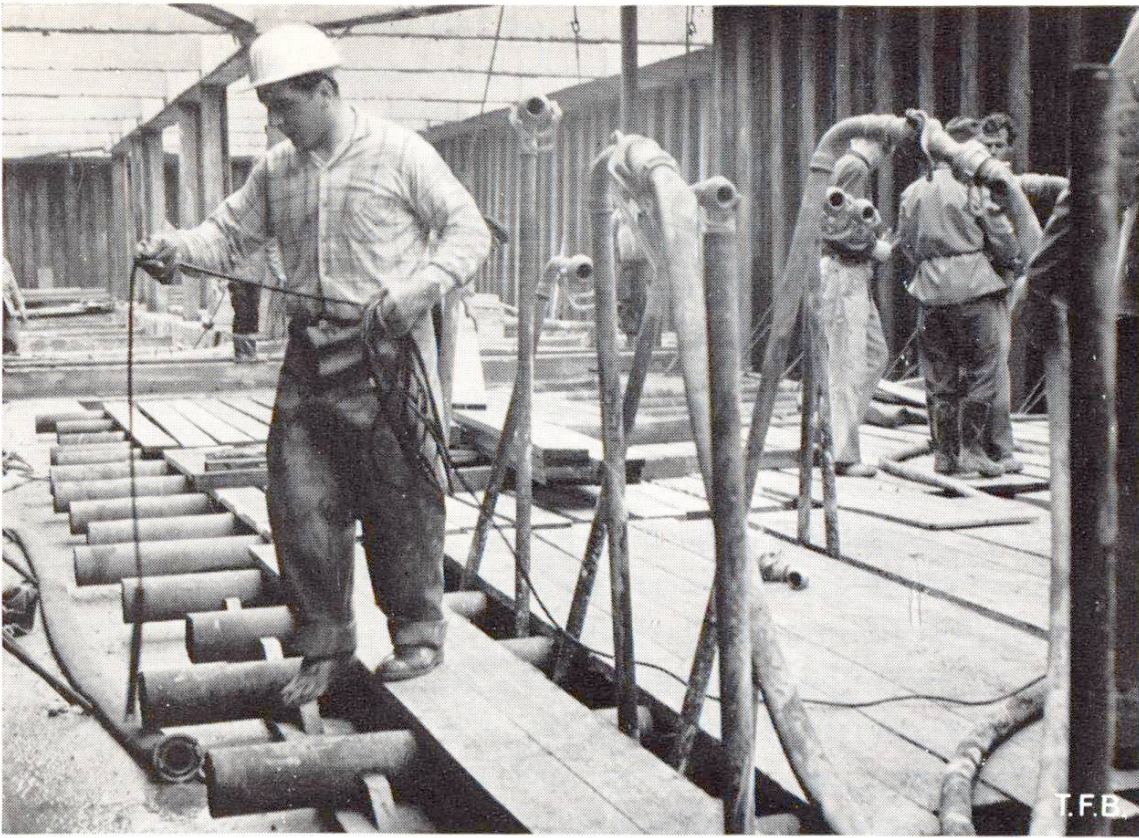
Fig. 3 Mise en œuvre de béton Colcrete sous l'eau pour la construction d'un radier d'écluse.
