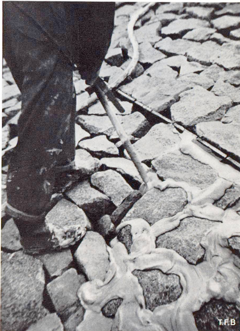
Fig. 2 Mise en œuvre de béton Colcrete. La pierraille est en place, le mortier répandu à la surface pénètre à 20 ou 30 cm. Pente du talus 1:1½ à 1:2½
