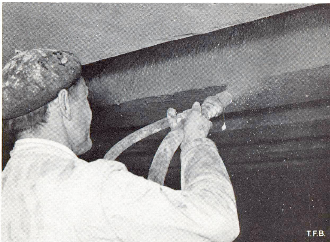
Fig. 4 Mortier Colgrout projeté. Projection par couches de béton Colcrete au moyen d'une lance Colcrete pour la construction d'une poutre de dalle dans un tunnel.
