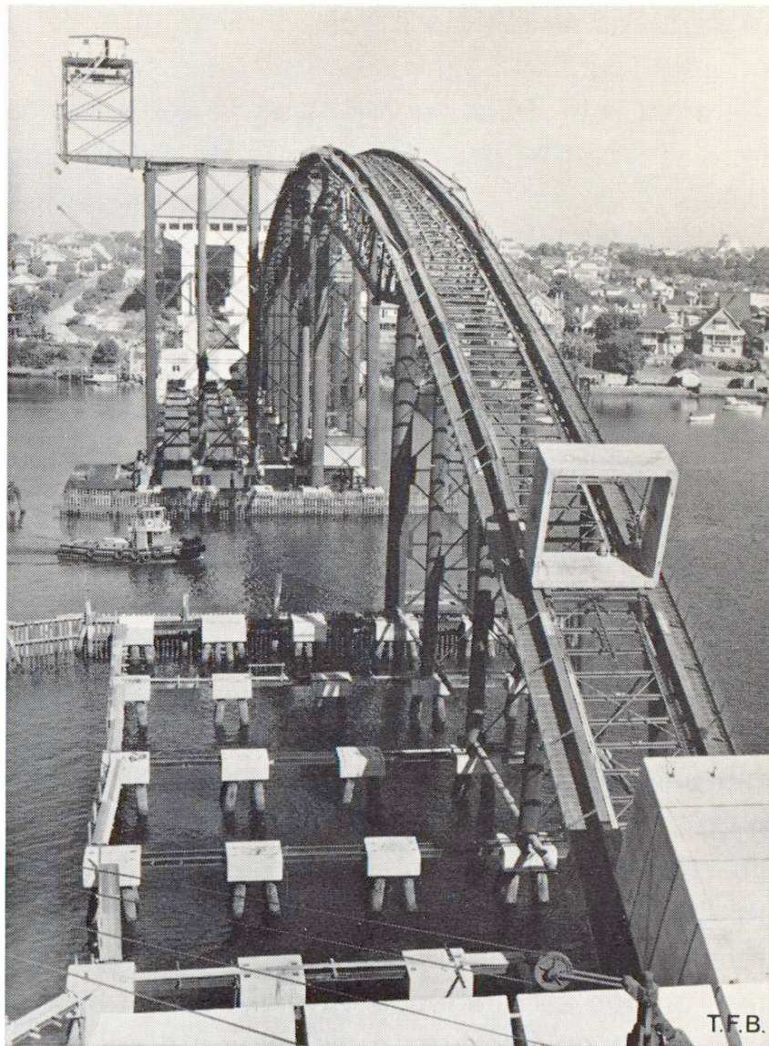
Fig. 3 Le cintre, avec la passe de navigation. Un des éléments d'un arc est en déplacement vers sa position définitive.
