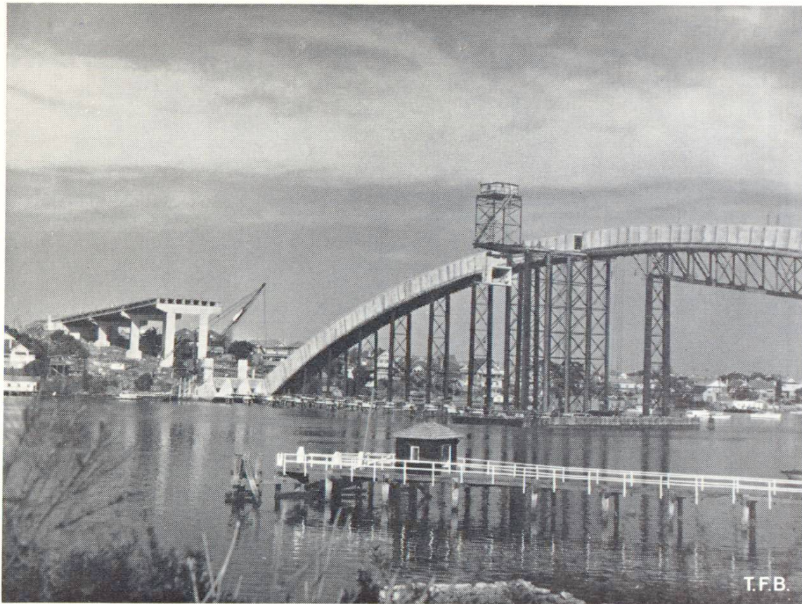
Fig. 4 Le dernier élément du premier arc est hissé. A gauche, le viaduc d'accès est déjà construit avec ses palées imposantes et son tablier en poutres préfabriquées.
