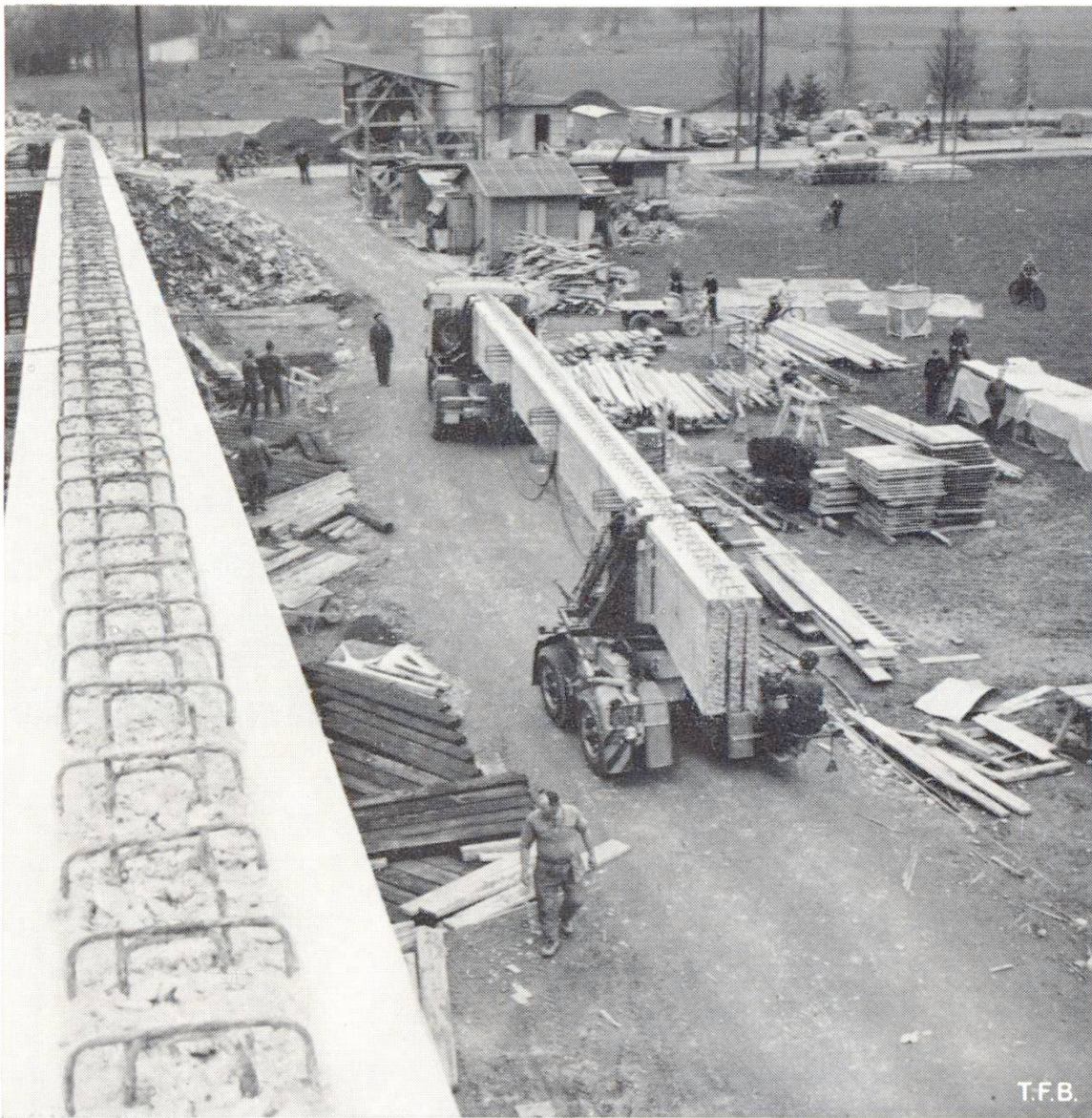
Fig. 3 Transport à pied d'œuvre des poutres préfabriquées en usine.
