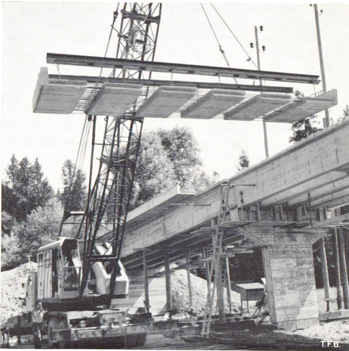
Fig. 6 Montage du tablier.
