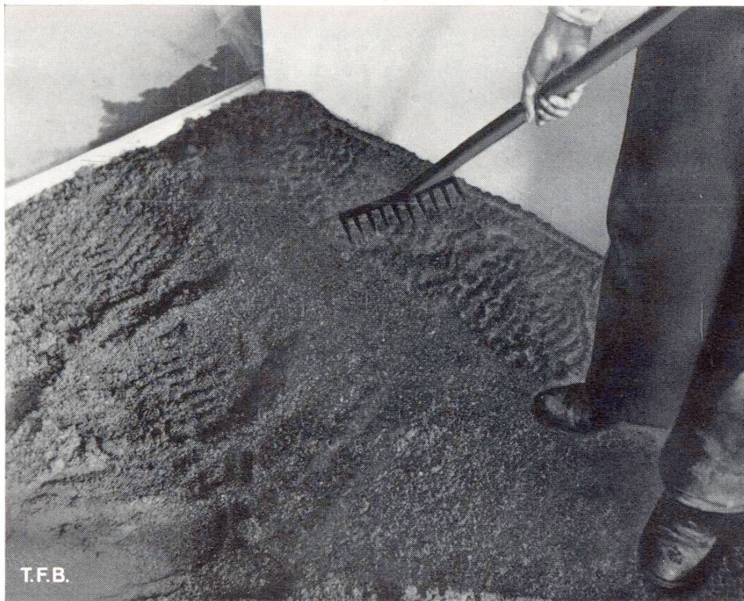
Fig. 1 Le mortier est égalisé sommairement au râteau
