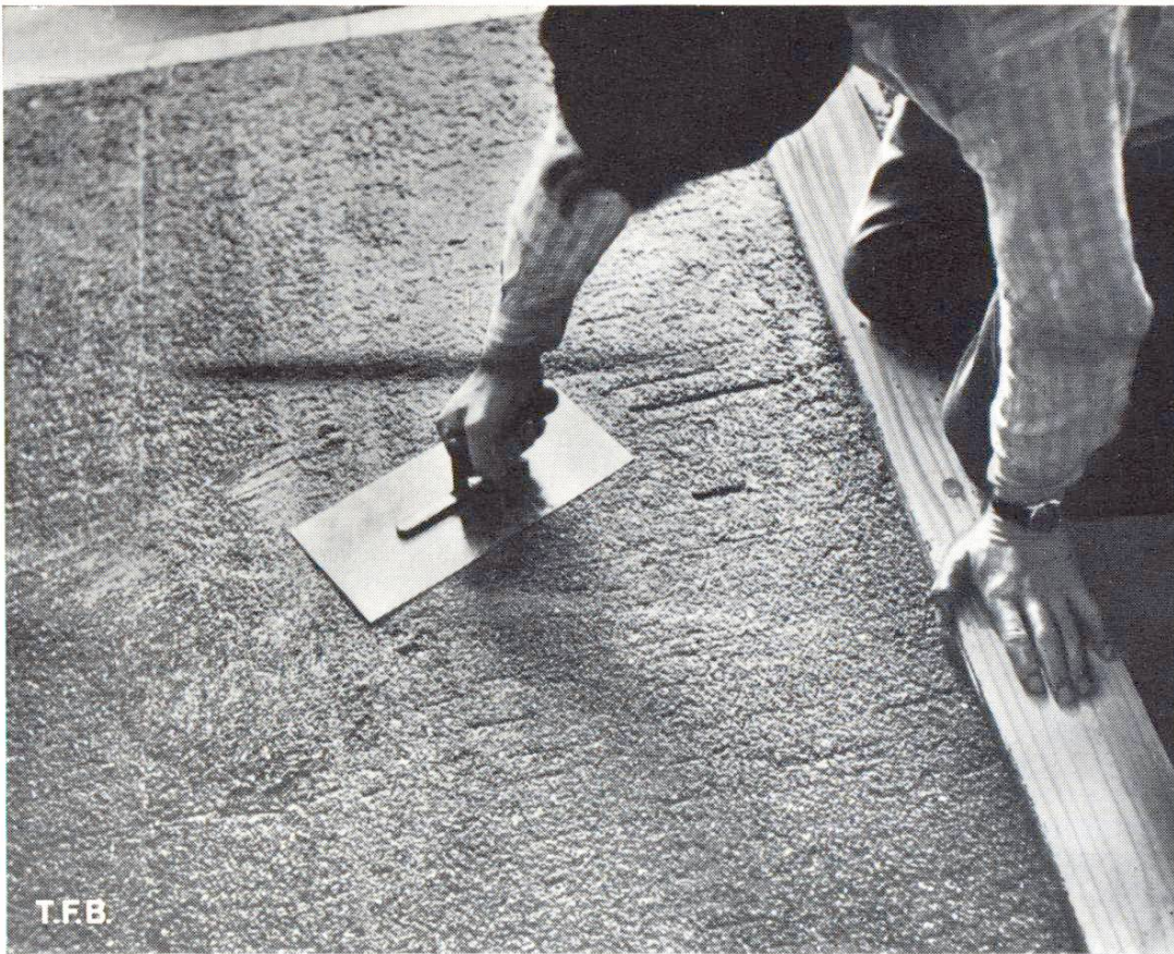
Fig. 4 Lissage de la chape au moyen d'une taloche spéciale
