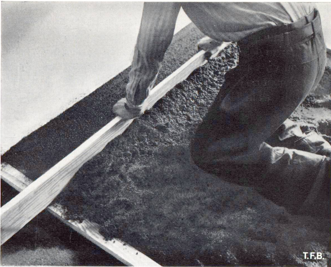
Fig. 2 Le mortier est réglé puis comprimé au moyen d'une latte
