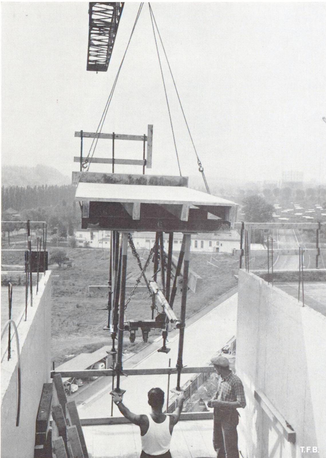
Fig. 2 Mise en place d'un élément de coffrage de plancher muni d'étais réglables et d'une passerelle de travail.
