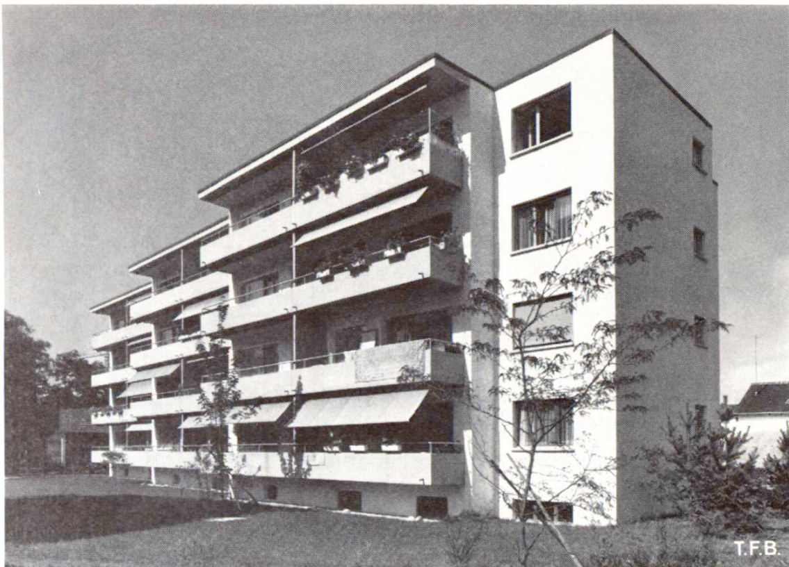
Fig. 1 Immeuble pour logements «Innere Hofäcker», Dietikon ZH
