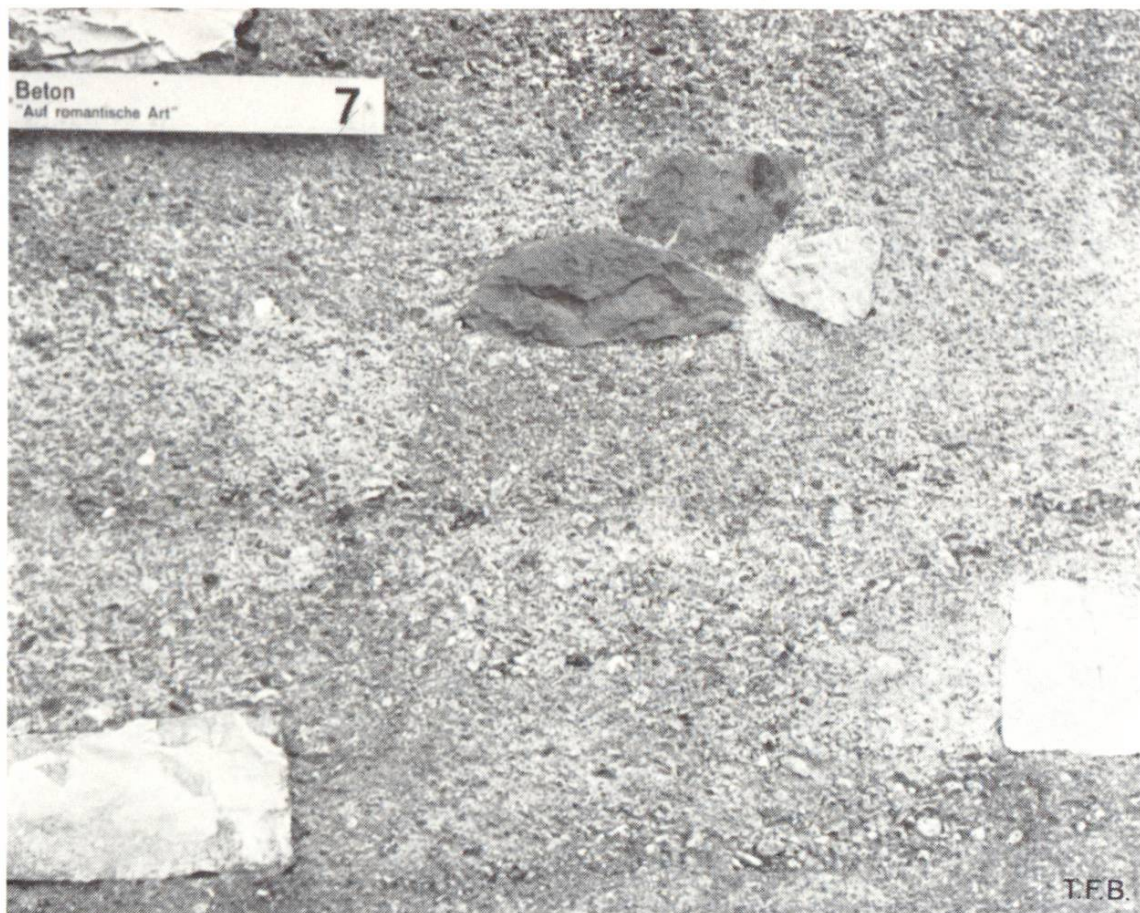
Fig. 7 et 8 Mur de soutènement ayant même fruit que celui des figures 1 et 2. Photos de 1962 et 1972. Béton traité à la grosse boucharde, avec pierres naturelles incorporées. L'aspect général de cette maçonnerie est devenu plus tourmenté. Certaines surfaces taillées des pierres ont fortement changé de teinte. L'augmentation des différences entre les gris du béton est probablement imputable à des variations locales du facteur eau:ciment du béton frais, et aux différences de porosité de la pâte de ciment qui en sont la conséquence.
