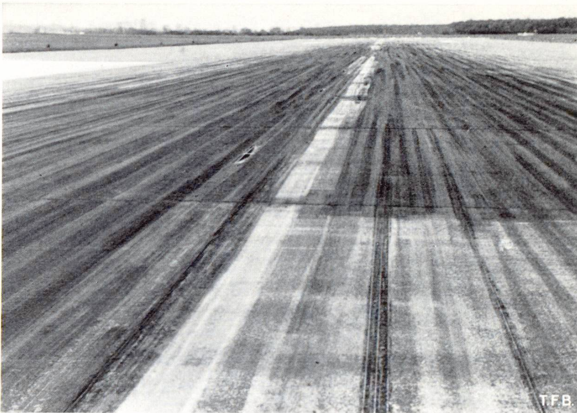
Fig. 3 Une zone de piste en béton recouverte de dépôts de caoutchouc. Au premier plan, à droite, une surface qui a été soumise au traitement, mais présente à nouveau les traces noires d'un avion ayant atterri depuis.
