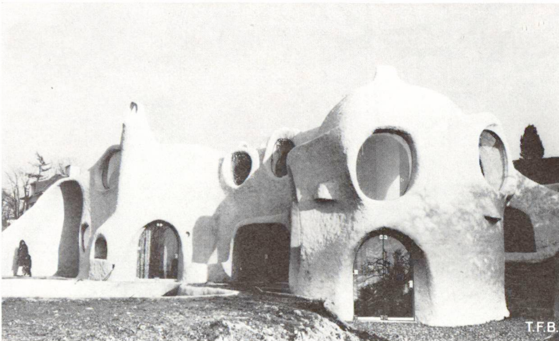
Fig. 6 Vue générale de la façade côté lac.
