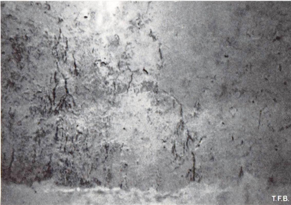
Fig. 8 Ségrégation d'eau dans un nid de gravier colmaté près d'un joint de bétonnage. La consistance du béton était certainement trop fluide.
