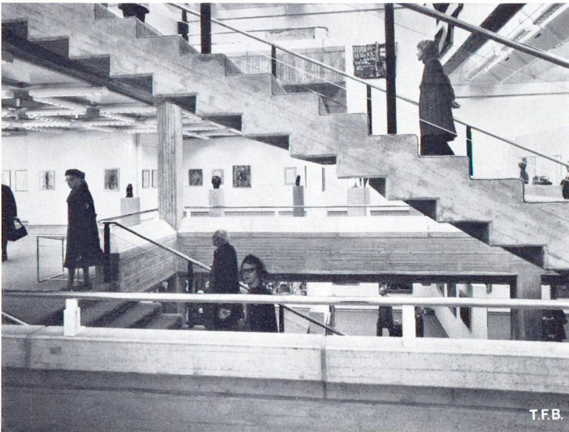
Fig. 3 Béton moulé sur place pour le nouveau bâtiment du Musée d'art de Zurich
