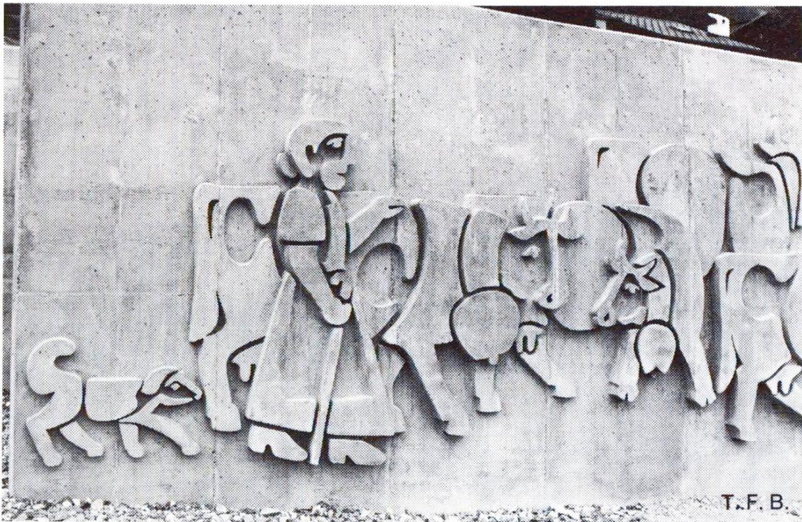
Fig. 9 Cette image de la fin du cortège alpestre montre l'aspect caractéristique du béton tel qu'il a été réalisé ici. On se rend compte également du soin et de la précision qu'il a fallu apporter au découpage des différentes parties du moule et à leur mise en place.
