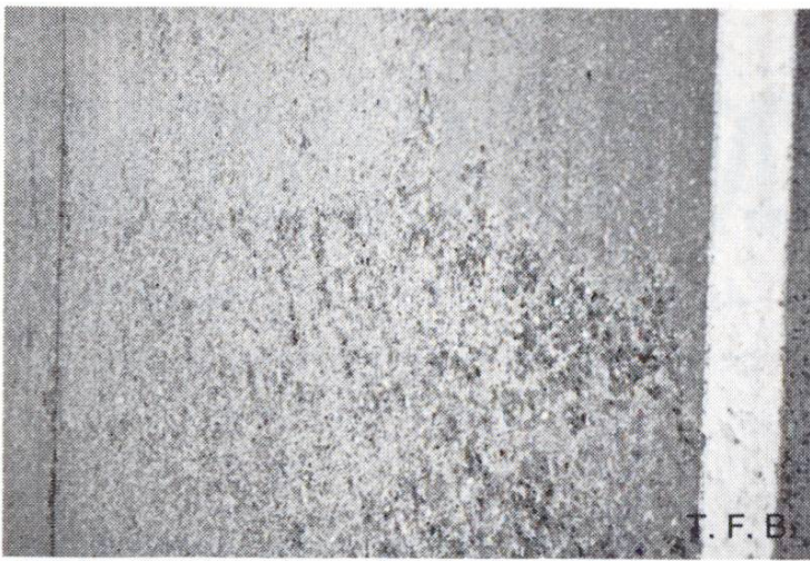
Fig. 1 Dégâts de gel en présence de sel sur une route en béton.
