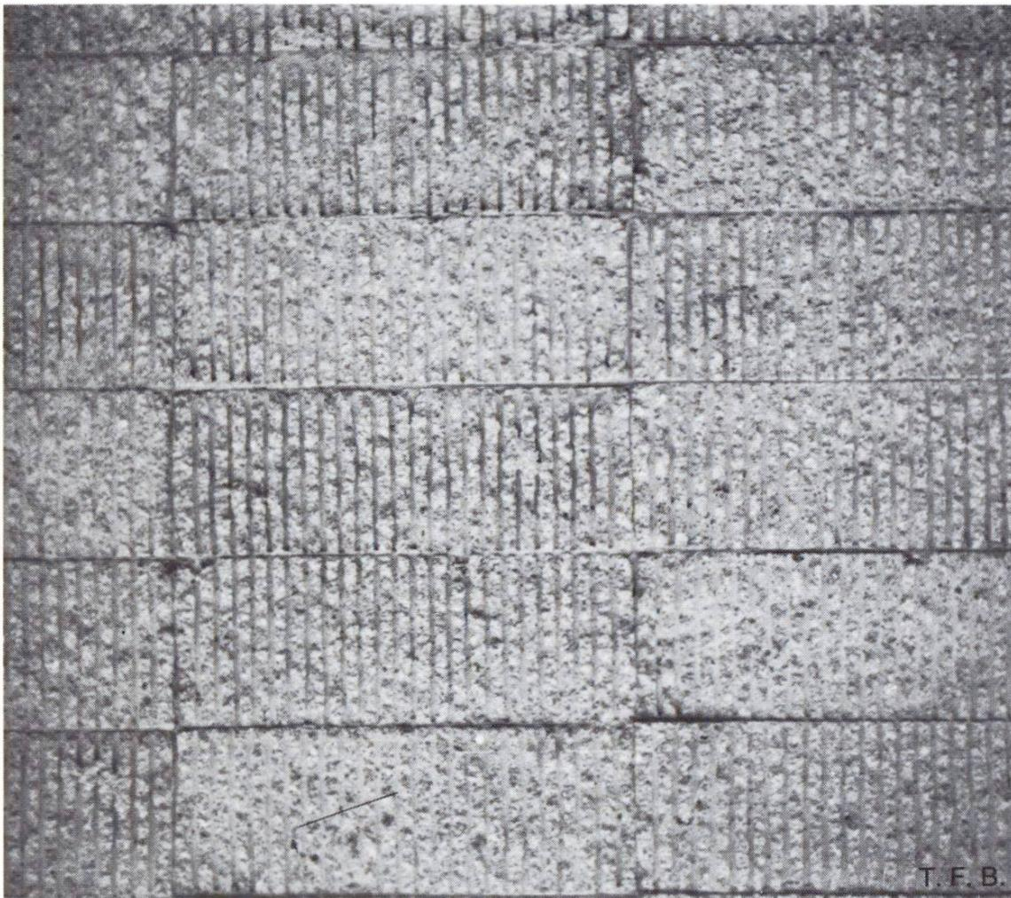
Fig. 8 Exemple d'une structure de surface qui ne peut pas être réalisée avec du béton moulé sur place.
