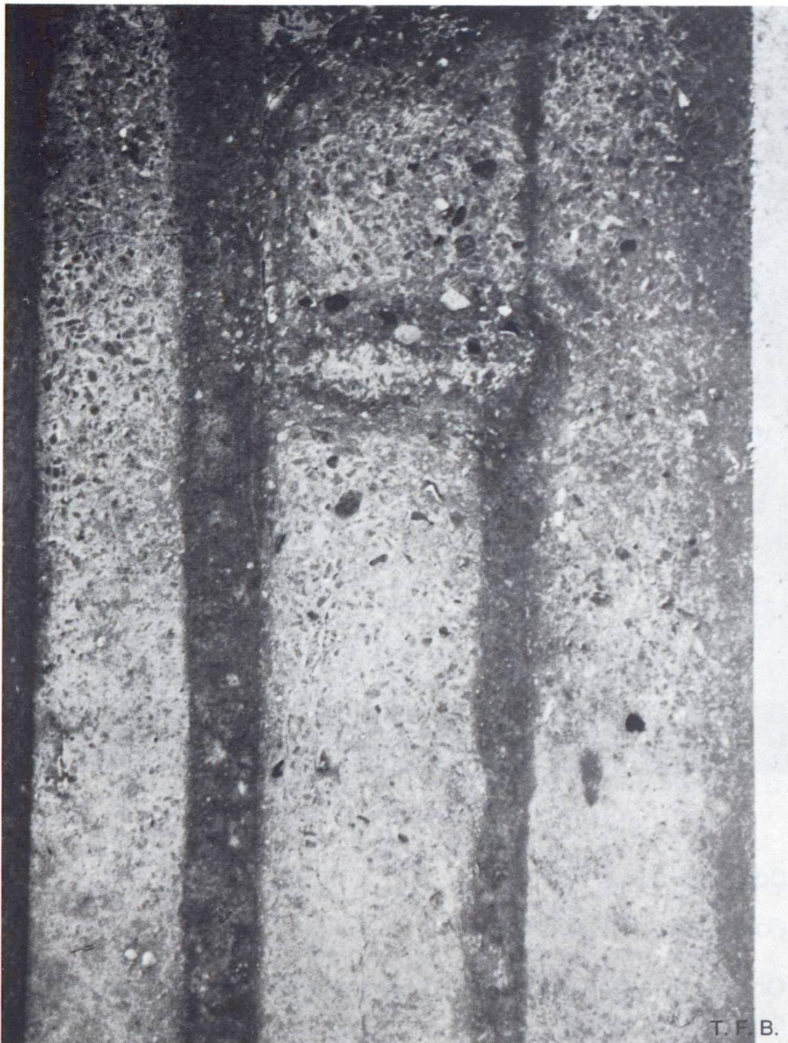
Fig. 10 Béton poli présentant des défauts en raison d'une ségrégation due au manque d'étanchéité du coffrage.
