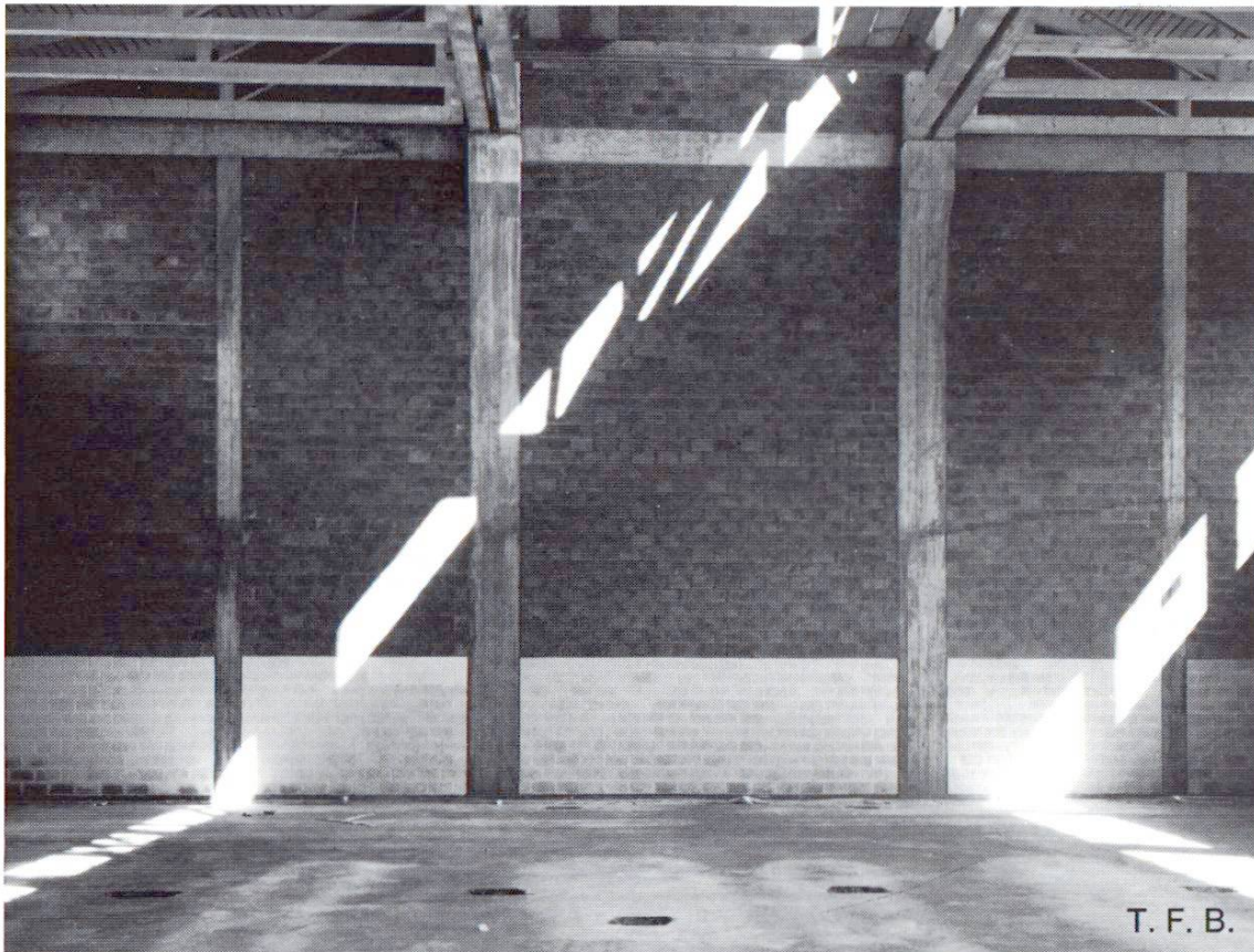
Fig. 6 Maçonnerie apparente en béton dans une usine.
