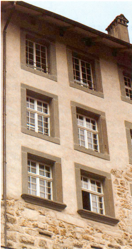
Fig. 6 Une partie de la façade nord.
